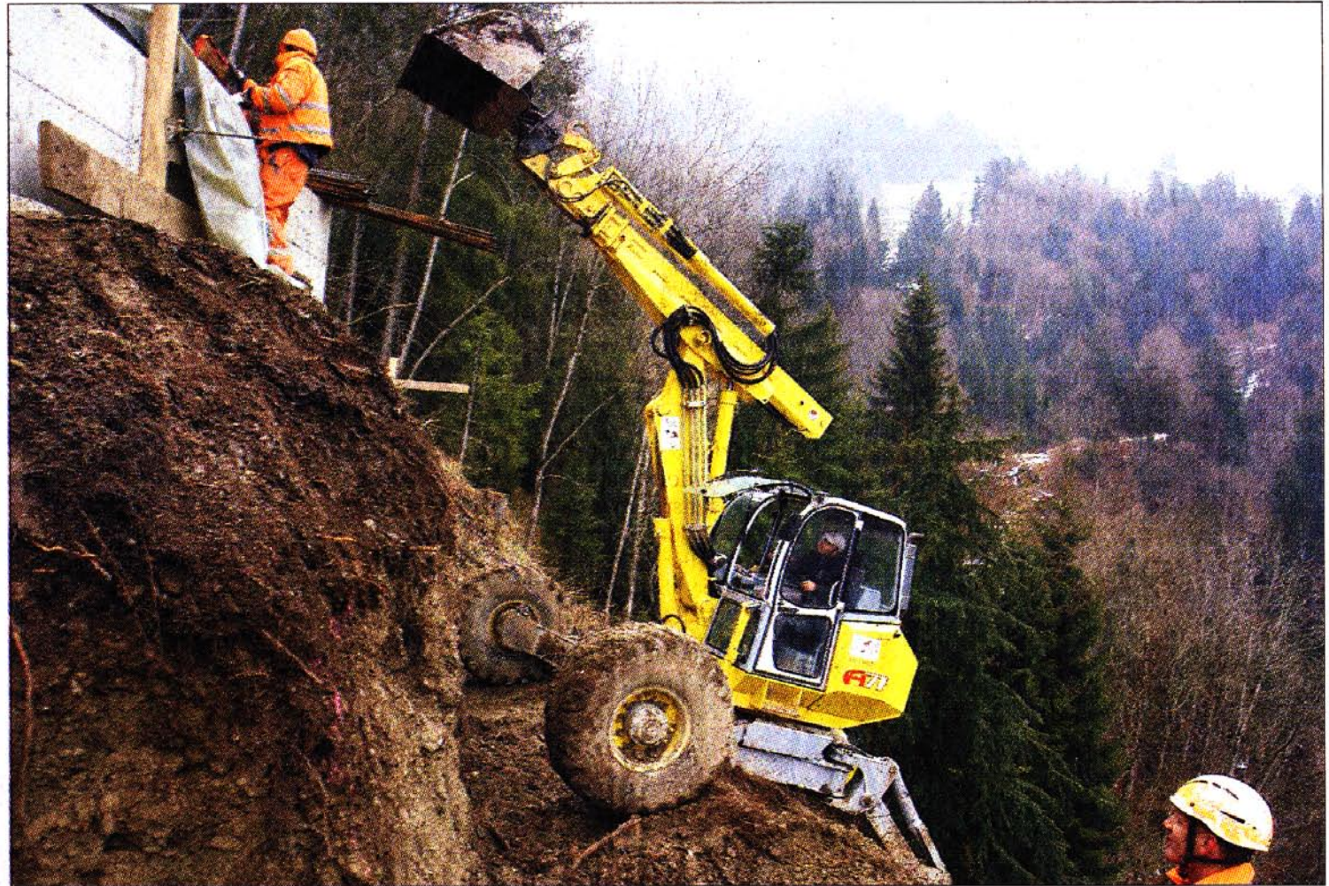
Arbeiten in schwierigem Gelände zur Sicherung der Fundamente.
